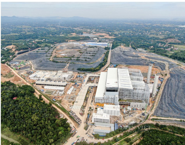
Nhà máy điện rác Sóc Sơn
