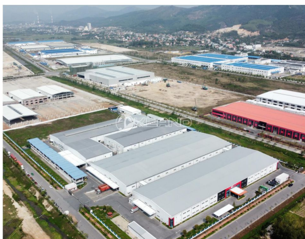
Khu công nghiệp Đông Mai, Quảng Ninh
