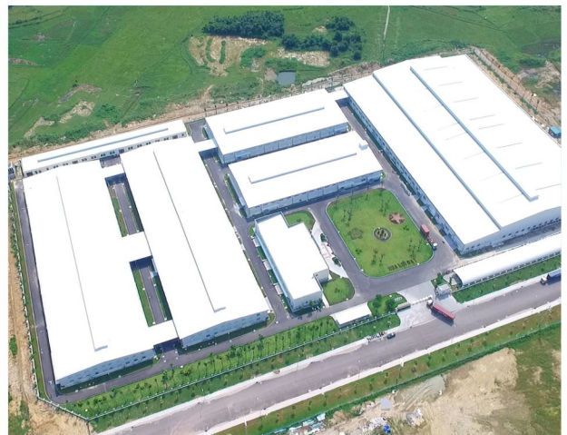
Nhà máy Hoa Lợi Đạt Hưng Yên
