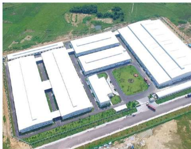
Nhà máy Hoa Lợi Đạt Hưng Yên
