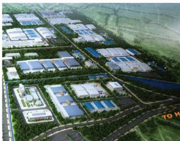
Khu công nghiệp Bim Sơn , Thanh Hóa
