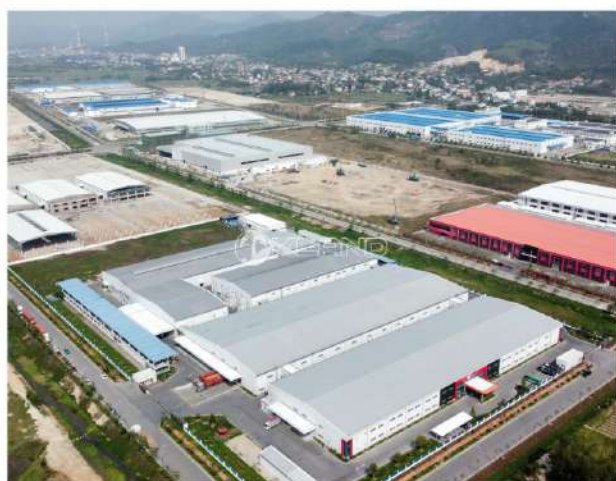
Khu công nghiệp Đông Mai, Quảng Ninh
