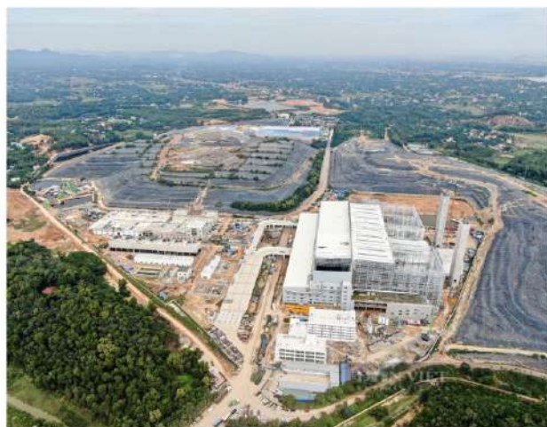
Nhà máy điện rác Sóc Sơn
